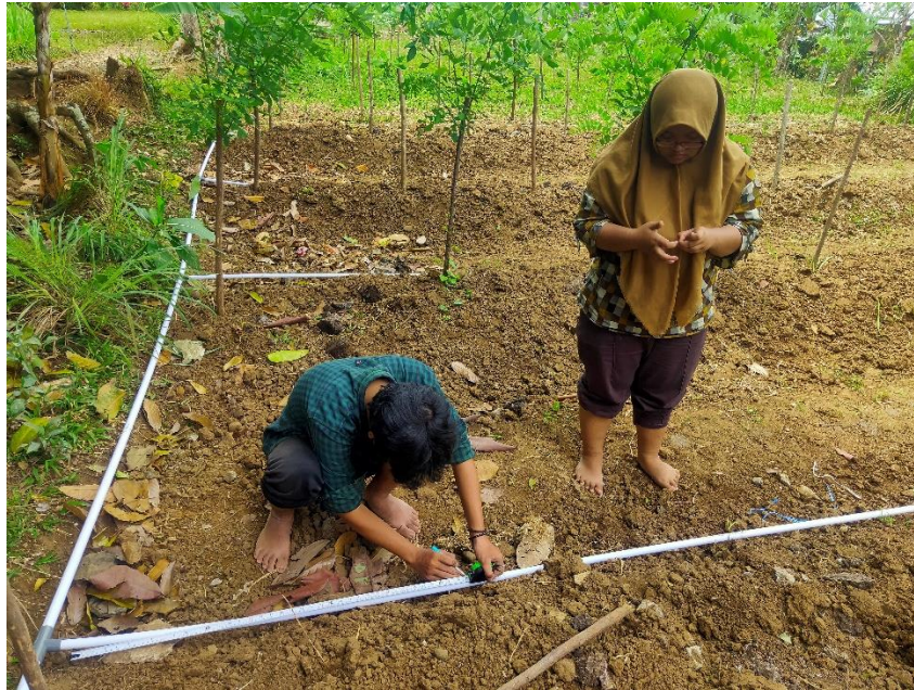
Gambar 3. Perakitan sistem irigasi tetes
