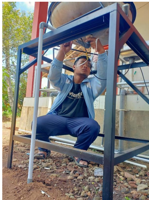
Gambar 4. Perakitan sistem irigasi tetes
