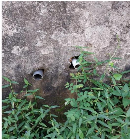
Gambar 2. Pembuangan limbah kantin langsung ke jalan umum
